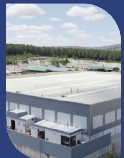
GRUPO DE INCENDIOS
